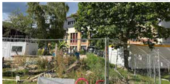
Travaux des annexes du Gymnase du Manège
